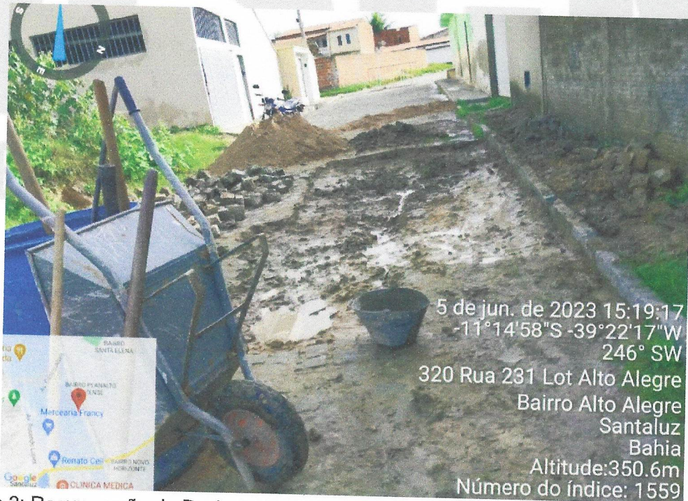
Imagem 2: Recuperação da Pavimentação em Paralelo na Rua Manoel pereira da silva/Sede
