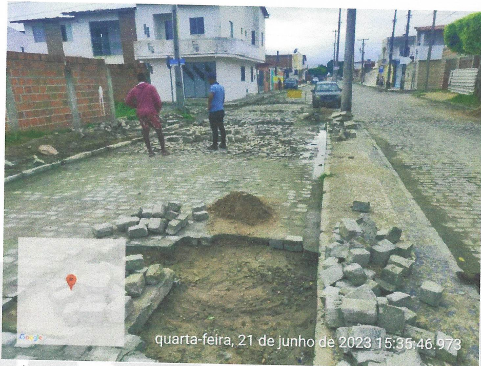
Imagem 13: Recuperação da Pavimentação em Paralelo na AV Rosendo Lopes/Sede
