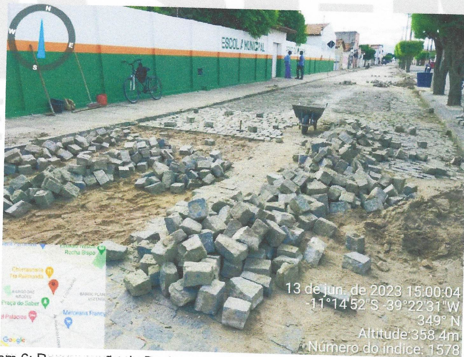
Imagem 6: Recuperação da Pavimentação em Paralelo na AV Rosendo Lopes/Sede
