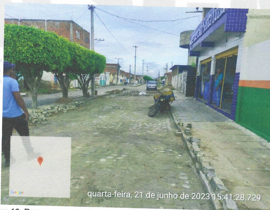
Imagem 16: Recuperação da Pavimentação em Paralelo na AV Rosendo Lopes/Sede
