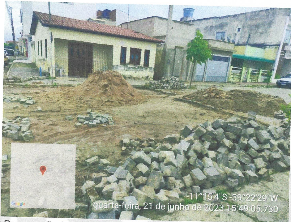
Imagem 11: Recuperação da Pavimentação em Paralelo na Rua Fernandes Lopes da Silva/Sede
