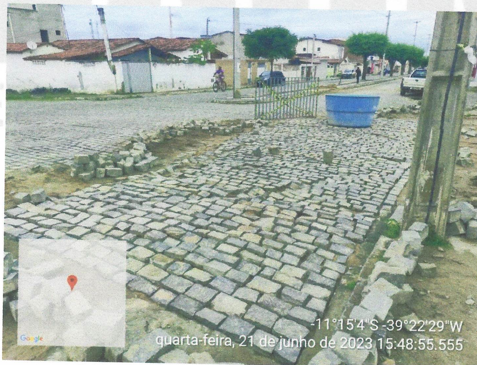
Imagem 10: Recuperação da Pavimentação em Paralelo na AV Rosendo Lopes/Sede RIACHÃO DO JACUIPE-BAHIA, 22 DE JUNHO DE 2023
