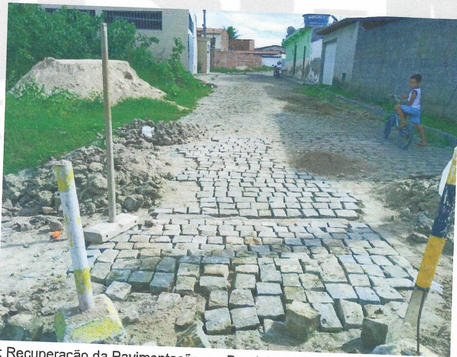
Imagem 3: Recuperação da Pavimentação em Paralelo na rua Manoel pereira da silva/Sede
