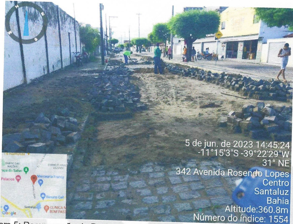
Imagem 5: Recuperação da Pavimentação em Paralelo na AV Rosendo Lopes/Sede
