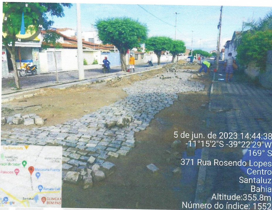
Imagem 9: Recuperação da Pavimentação em Paralelo na AV Rosendo Lopes/Sede
