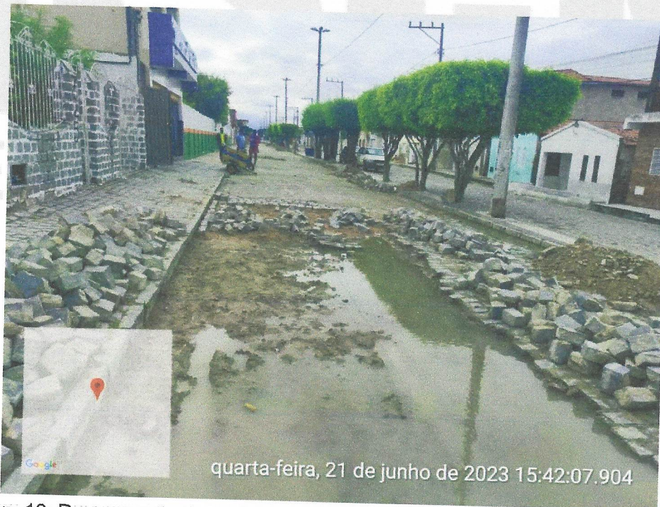
Imagem 12: Recuperação da Pavimentação em Paralelo na AV Rosendo Lopes/Sede
