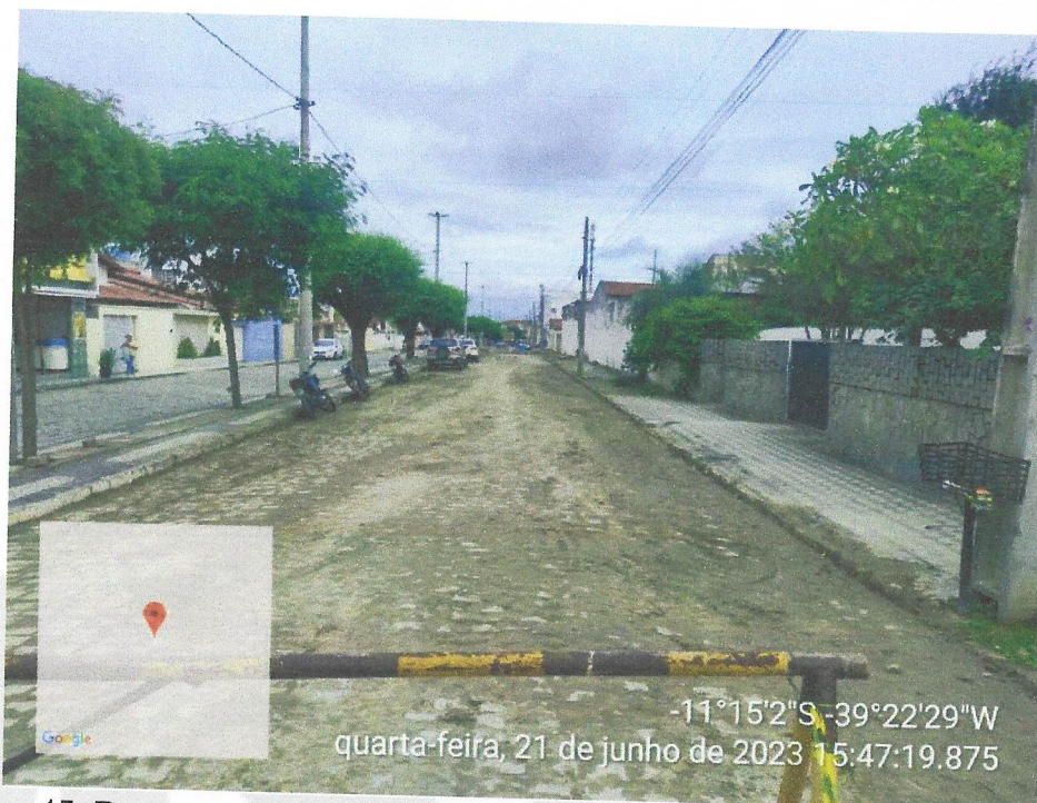
Imagem 15: Recuperação da Pavimentação em Paralelo na AV Rosendo Lopes/Sede
